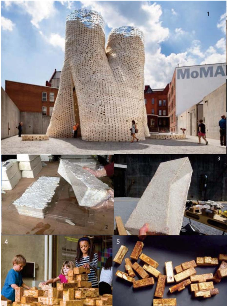
Fig. 1: La torre «Hy-Fi» construida con ladrillos de micelio en el MoMAPS1 de Nueva York. Figs. 2-3: Ladrillos fabricados con micelio (fotografías obtenidas de [www.theliving-newyork.com](http://www.theliving-newyork.com)). Figs. 4-5: Ladrillos fabricados por Mycoworks (fotografías obtenidas de [www.mycoworks.com](http://www.mycoworks.com)).
